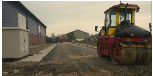
Foto: Asfalteren 2 e fases
